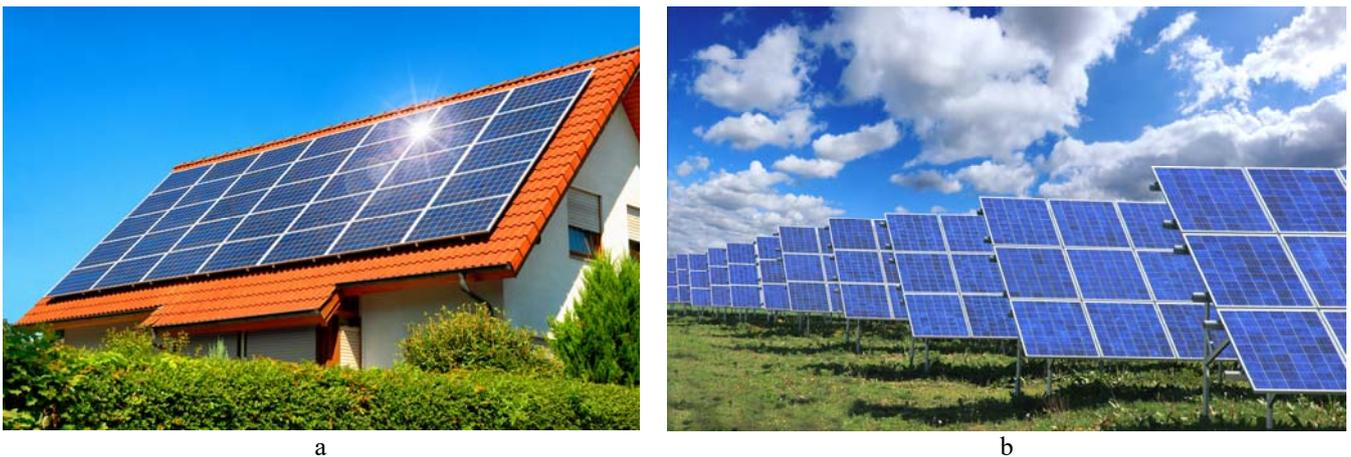
**Fig. 7.2** – Esempi di impianti fotovoltaici: a) Su tetto complanare al tetto inclinato – b) A terra.
