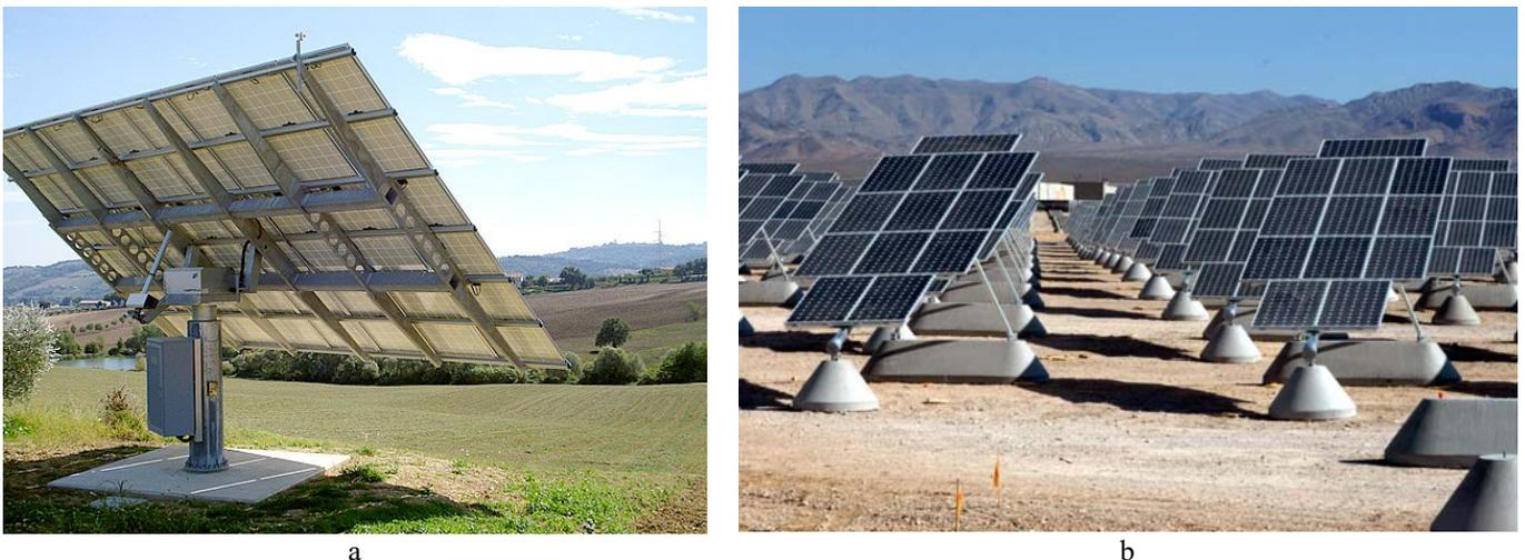
**Fig. 7.39** – Esempi di strutture ad inseguimento solare: a) Per installazioni a terra – b) Campo solare.
