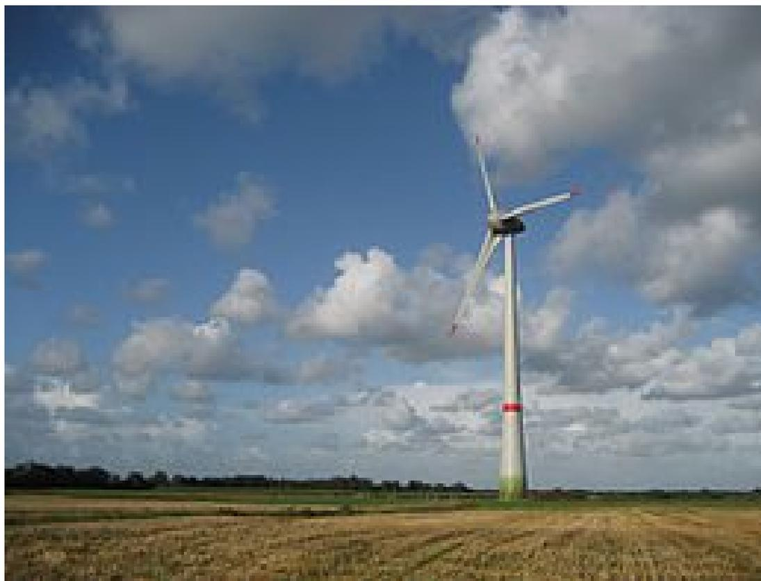
L'aerogeneratore **Enercon E-126** è il più grosso e potente modello di turbina a vento prodotto nel mondo fino al 2009. Viene costruito dal produttore tedesco Enercon. Con la gondola del generatore a 135 m di altezza, un diametro del rotore di 126 m e un'altezza totale di 198 m, questo mastodontico modello può generare fino a 7 MW di energia per turbina.
